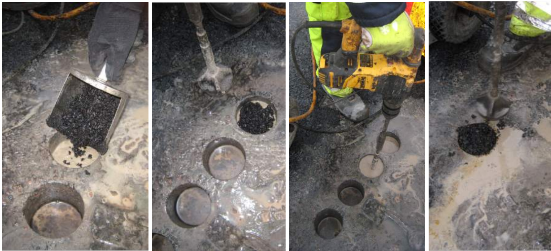
Figur 5.4 Exempel lagning med kallasfalt, dagens metod.
