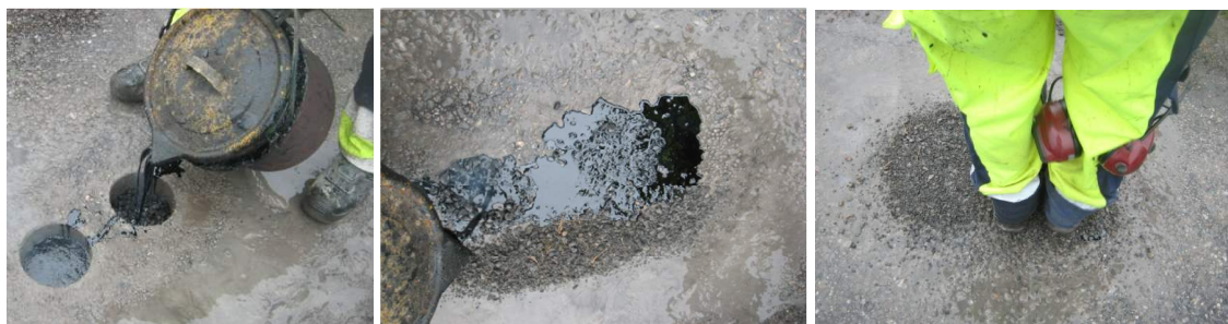
Figur 5.3 Exempel lagning med gjutasfalt, dagens metod.
